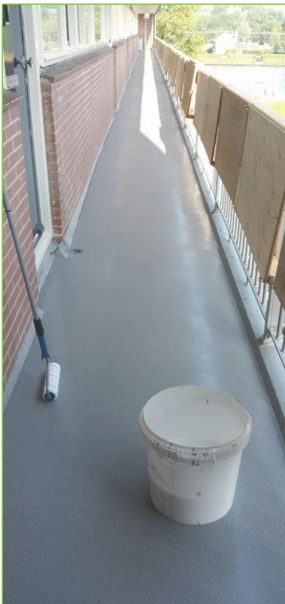
Aanbrengen seal laag
