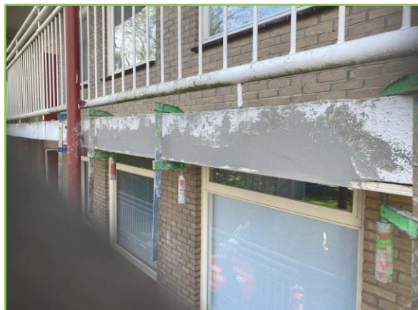
Bekiste betonreparaties te Utrecht
