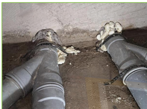
Injecteren doorvoeren te Den Haag
