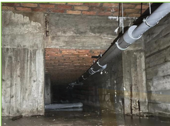
Injecteren kolommen te Rotterdam
