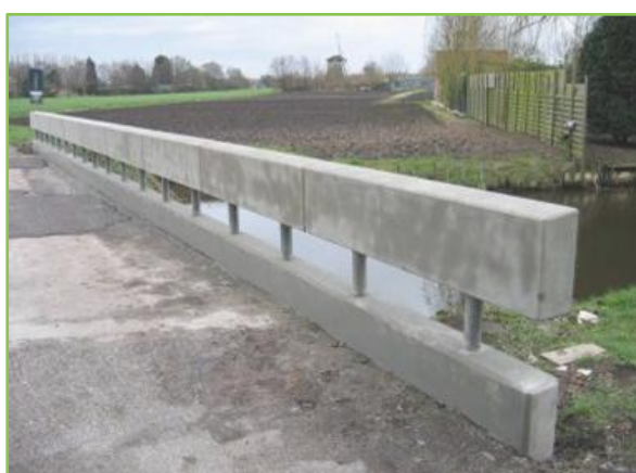
Brugrenovatie te Breukelen
