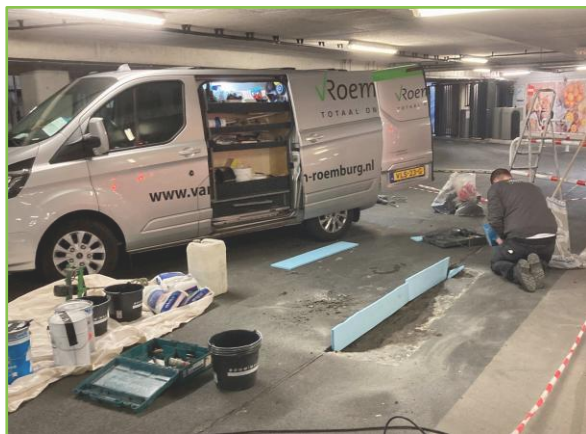
Garagevloer coaten en dilatatie te Hillegom
