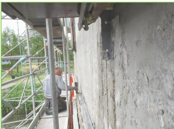
Handmatige betonreparaties te Amersfoort
