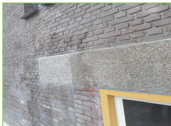
Repareren en kitten lateien te Lelystad
